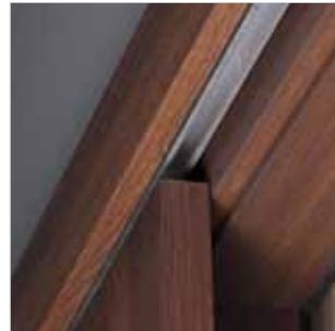
Gleitschiene des vor der Wand laufenden Türsystems
